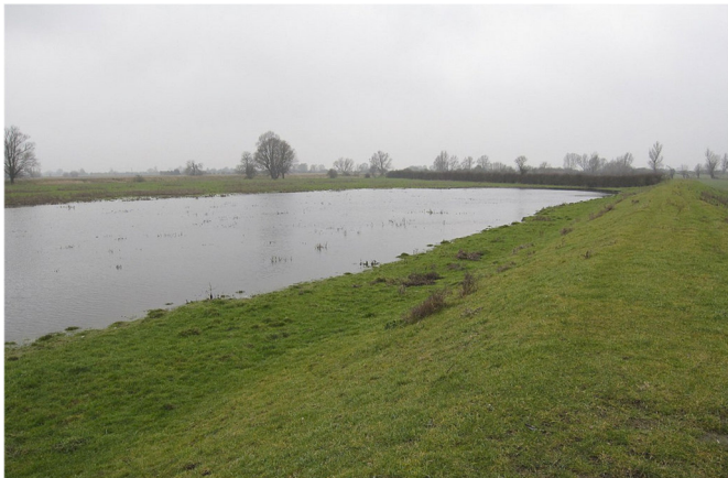
Bacino di detenzione
