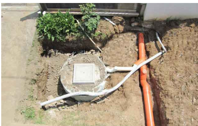
Realizzazione di pozzo perdente
