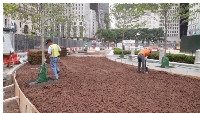
Sistemi CU-Structural Soil prima della pavimentazione
